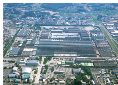
本社・上尾工場
