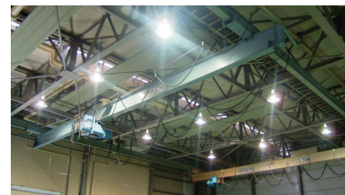
LED照明、高効率照明への変換
