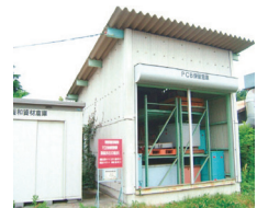
PCB廃棄物保管倉庫
