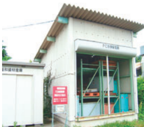
PCB廃棄物保管倉庫
