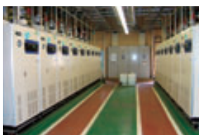
小型貫流ボイラー（上尾工場）
