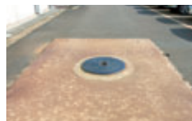
廃油は、地下タンクなどに回収した後、適正に処理されます
