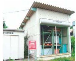
PCB廃棄物保管倉庫
