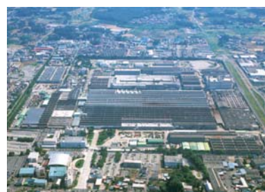
本社・上尾工場
